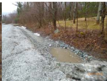
Bassin sur le chemin de la Source
